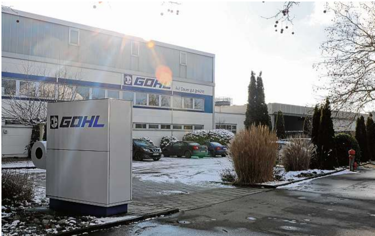
Für Mitarbeiter von Gohl-KTK scheint derzeit kaum die Sonne: 20 Menschen sind laut Geschäftsführung von einer Restrukturierung betroffen. Unklar ist, wie es für sie weiter geht - und wie hoch die Abfindung ausfallen wird. BILDER: ISABELLE ARNDT
